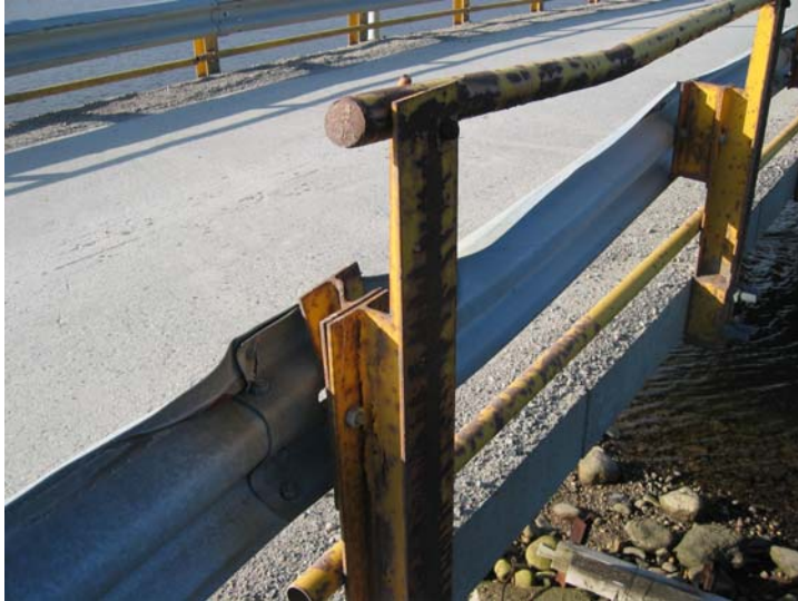
Rekkverk som er til dels mye korrodert og kjørt i stykker.
