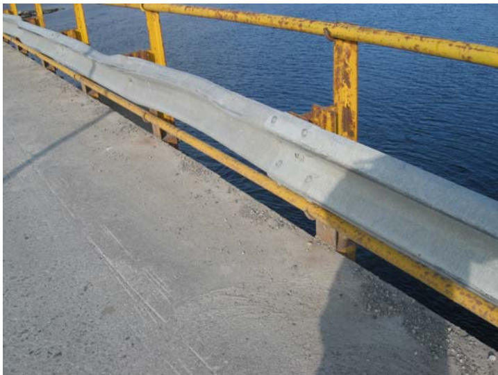
Rekkverk som er til dels mye korrodert og kjørt i stykker.
