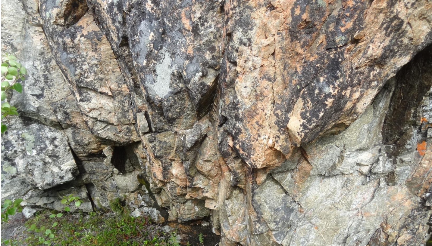
E105 – Tunnel under Trifonhøgda Foto 6:
