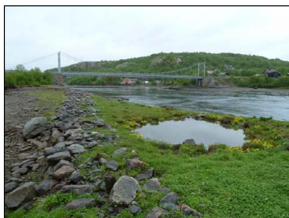
Elvekanten i retning brua, sett mot sør
