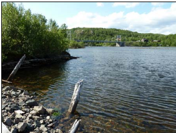
Dagens bru ved Elvenes sett mot sørøst
