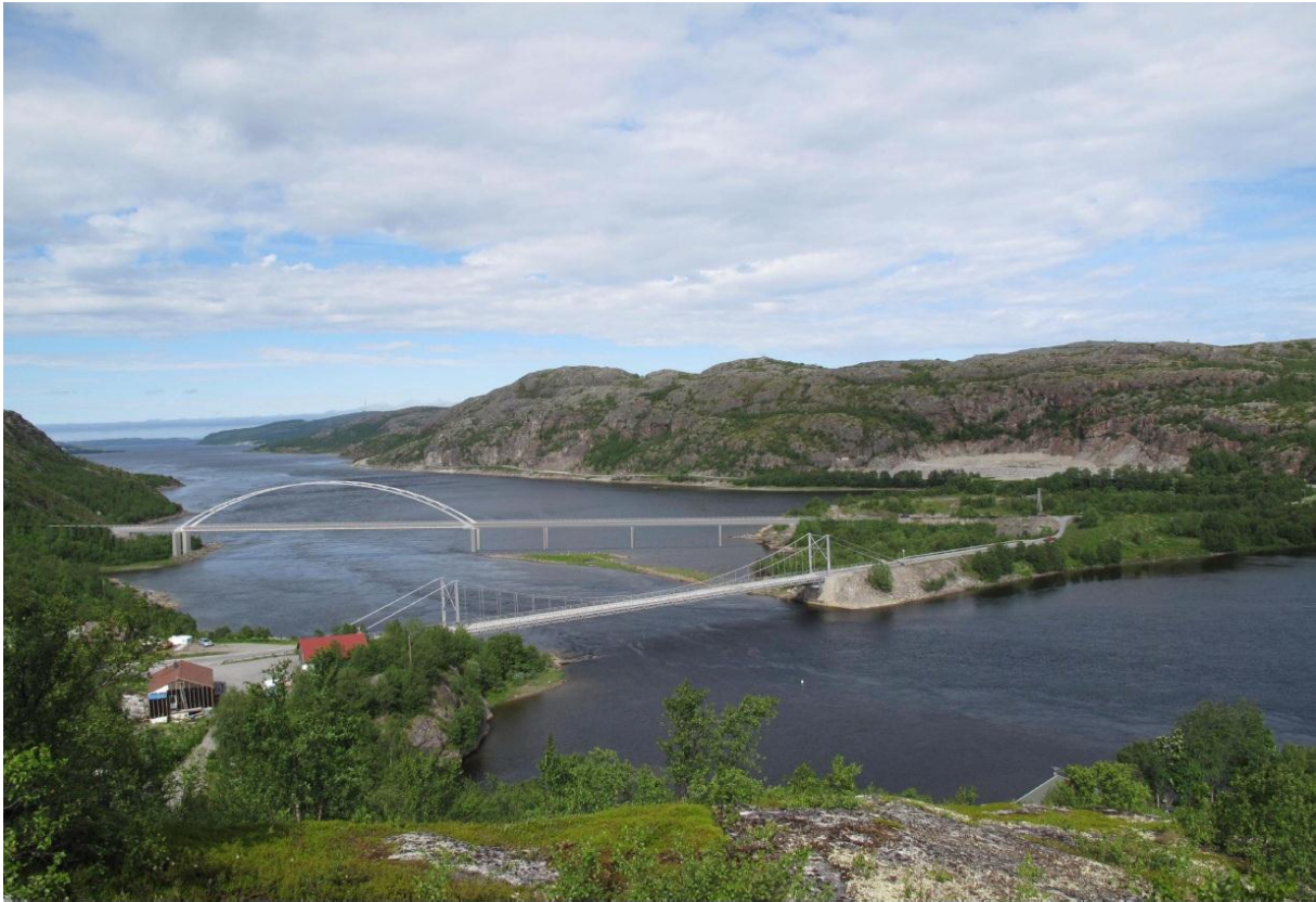
Figur 10 - Nettverksbuebru og viadukt. Bildet er tatt ved høyvann. Fotomontasje: Statens vegvesen
