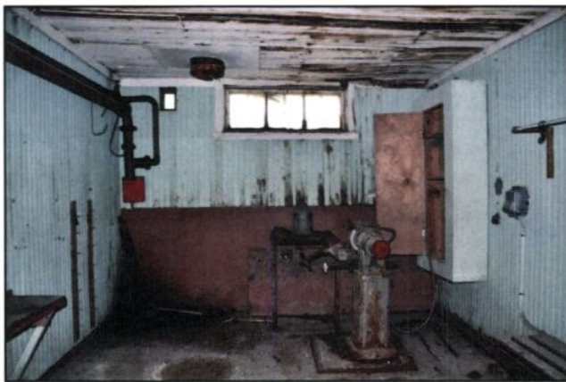
Bildet til venstre viser rommet sett mot øst, og bildet til høyre viser rommet sett mot vest. Gulvet er i støpt betong og veggene kledd i panel og delvis
