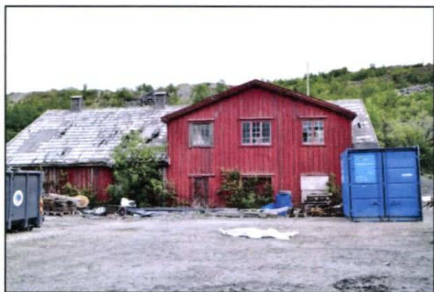
Figur 5 - Rørbua mot sør, juni 2013
