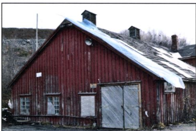
Figur 6 - Rørbua mot nord, oktober 2013
