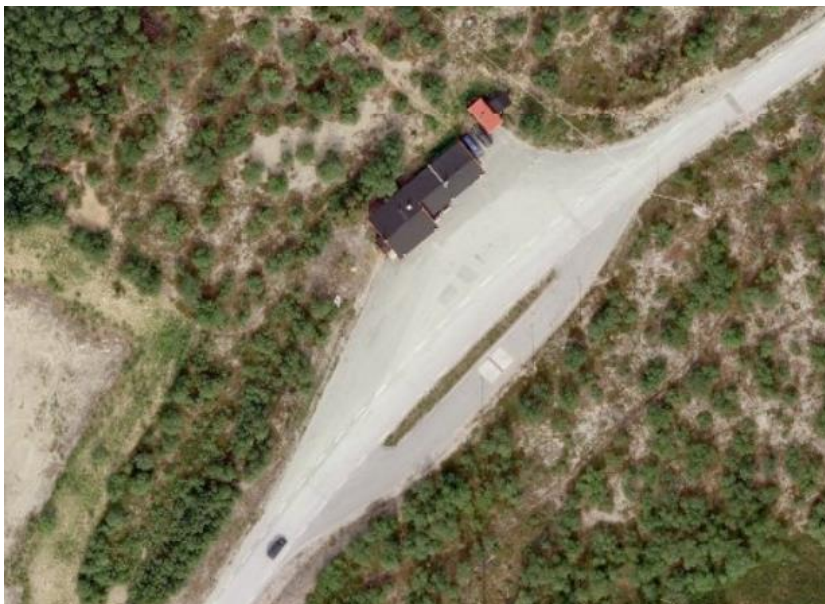
Figur 17 Veiløsning ved eksisterende tollstasjon. Skuterløype kan skimtes i høyre kant av bildet
