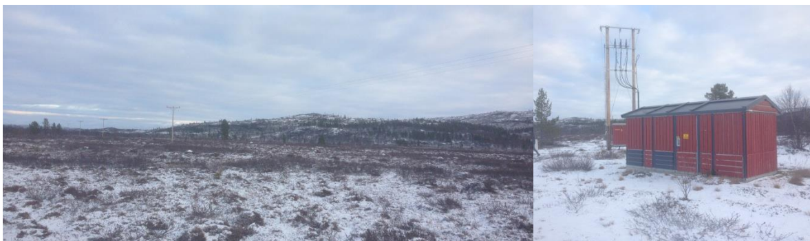
Figur 19 Høyspentledning langs varslingsområdet. Trafostasjon nær finskegrensen
