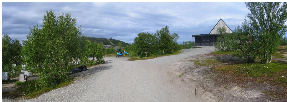
Fig. 7. Utsikt mot nordvest, kapellet til høyre i bildet.
