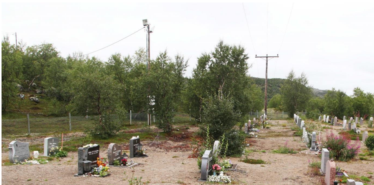
Fig. 22. Lavspent ligger her i kanten av kirkegårdsarealet. Strømuttak plassert like inntil masten.
