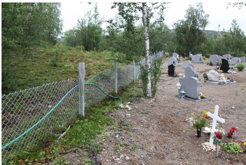
Fig. 18. Vannledning ligger i dag på bakken, her festet til gjerde.
