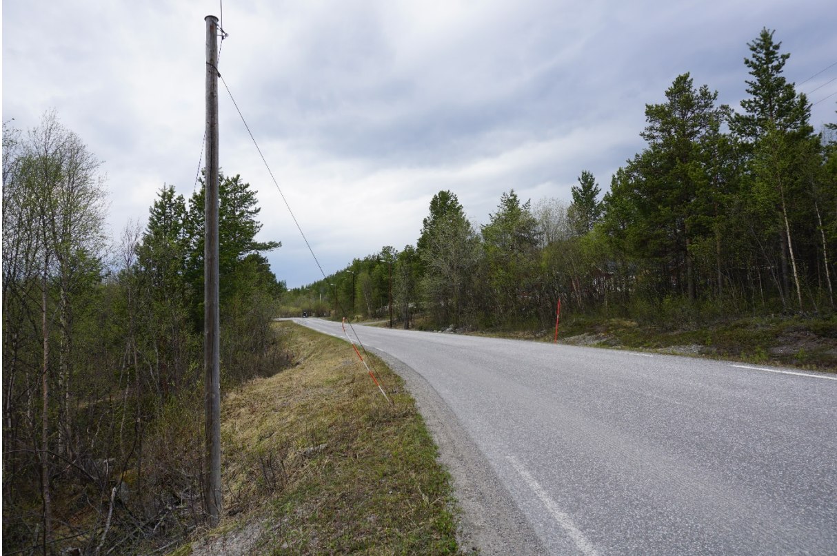
Figur 7: Bardunering, sikkerhetsrisiko langs vegen
