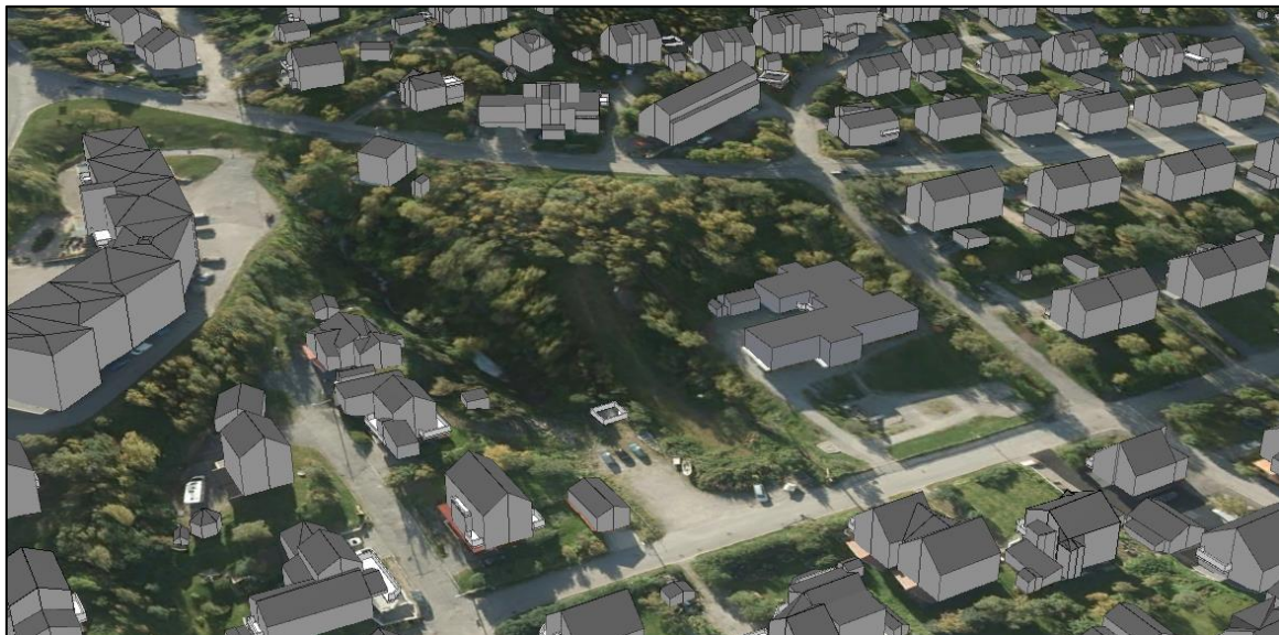
Figur 8: Skråbilde av planområdet, med eksisterende bebyggelse
